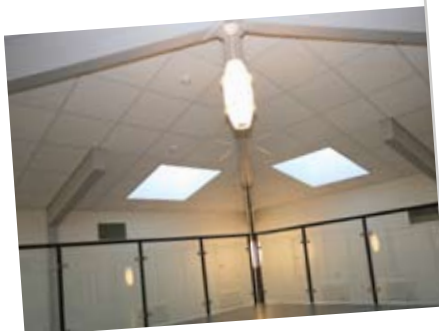
Vardeneset skole, Stavanger
